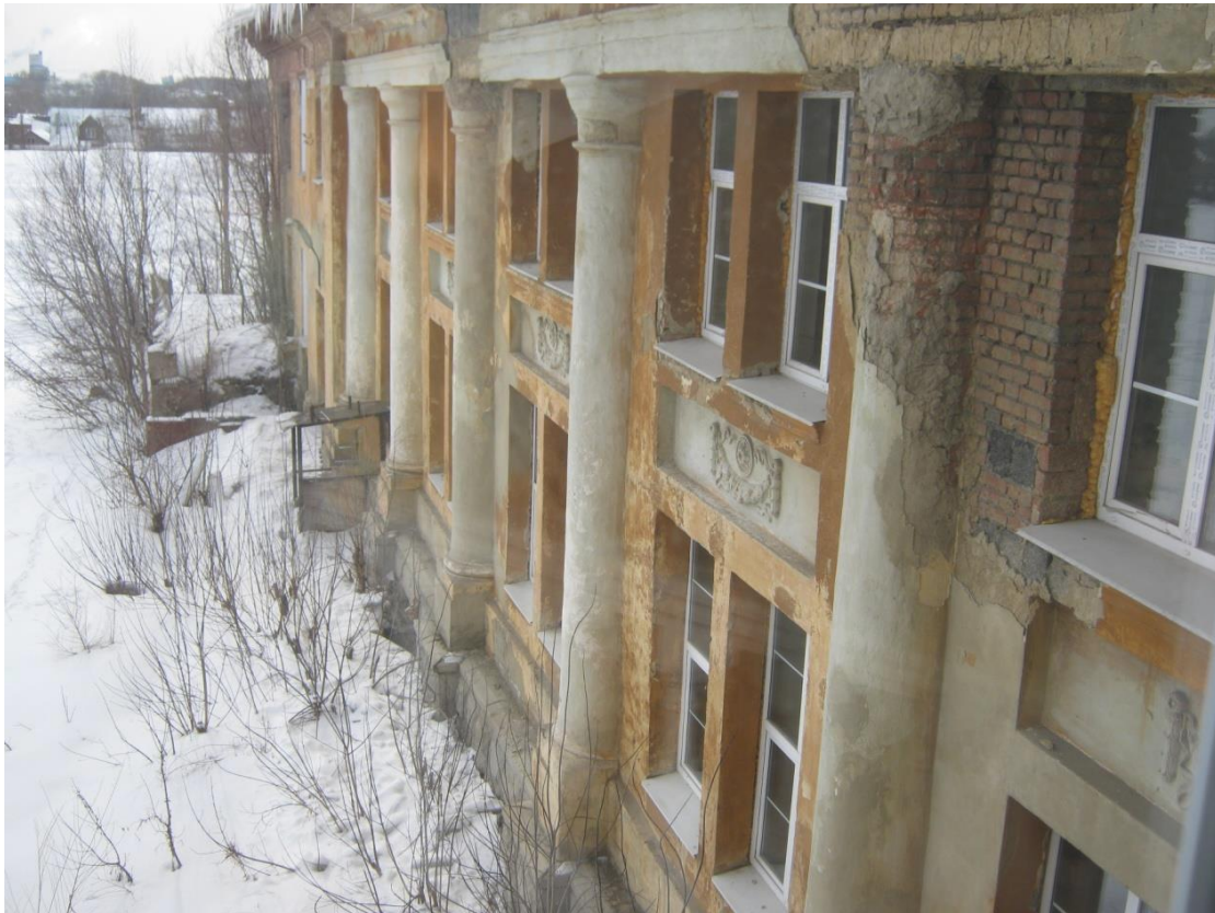
Фасад здания до ремонта
