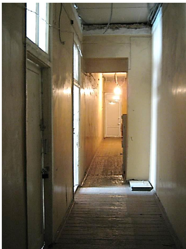
Коридор до ремонта
